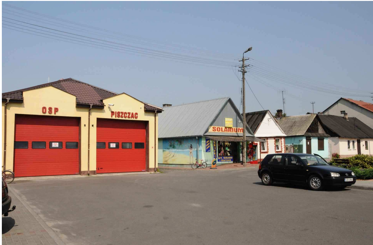
Remiza Strażacka w Piszczacu
